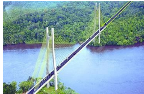
Le pont sur l'Oyapock qui relie la Guyane au Brésil.
